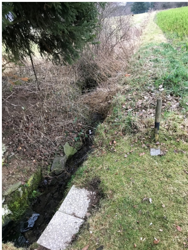
Abb. 6: Ansicht von Norden – verrohrter bzw. offener Entwässerungsgraben im Osten, Foto Jocham Kessler Kellhuber GmbH (Januar 2022)
