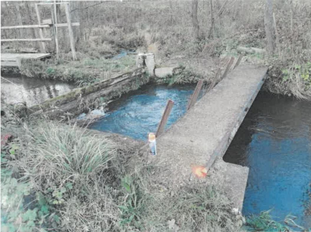
Bild 5.10: Dammbalkenverschluss mit Bediensteg
