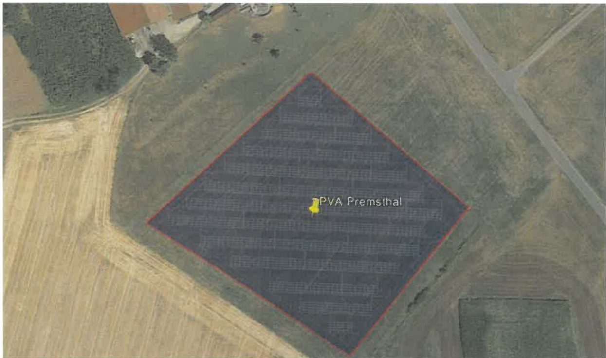
Bild 2.1.3: Detailansicht der PV-Fläche (Quelle: Google Earth/SolPEG)
