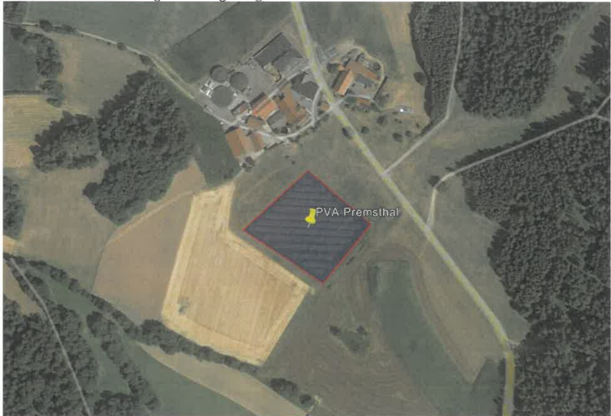
Bild 2.1.2: Detailansicht der PV-Fläche (Quelle: Google Earth/SolPEG)
