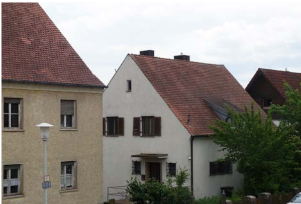
Wohngebäude der zweiten Hälfte des 20. Jahrhunderts mit Sanierungs- und Modernisierungsbedarf
