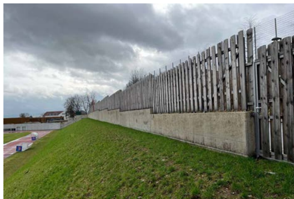
Böschung am Stadion - hier soll eine neue Tribüne entstehen
