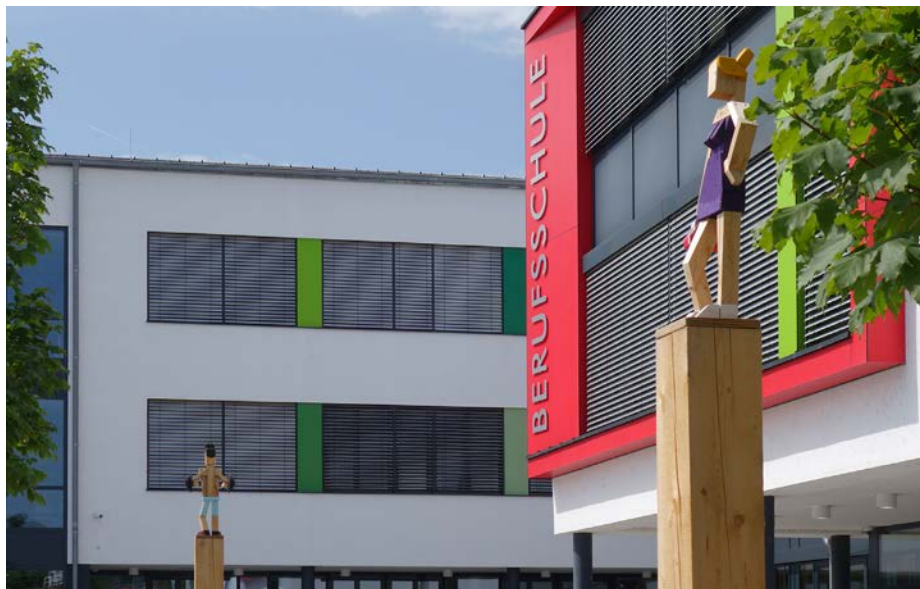
Die Kreisstadt Cham ist ein wichtiger Bildungsstandort der Region. Der Neubau der Staatlichen Berufsschule ist Teil des Bildungsstandortes um den "Campus Cham" am südlichen Rand des Untersuchungsgebietes in der Badstraße
