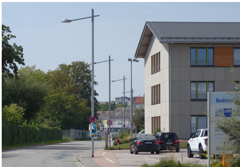
Transformationsprozess in Quartier 4, Neubau Verwaltungsgebäude
