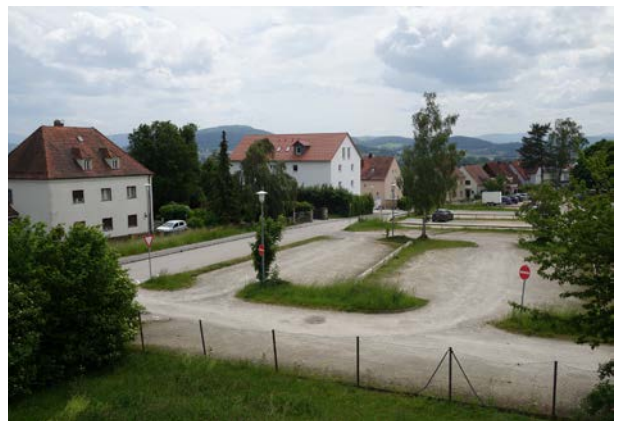
Auch der Schülerparkplatz am Schulberg kann für höherwertigere Nutzungen entwickelt werden. Anliegende Gebäude haben teilweise Sanierungsbedarf
