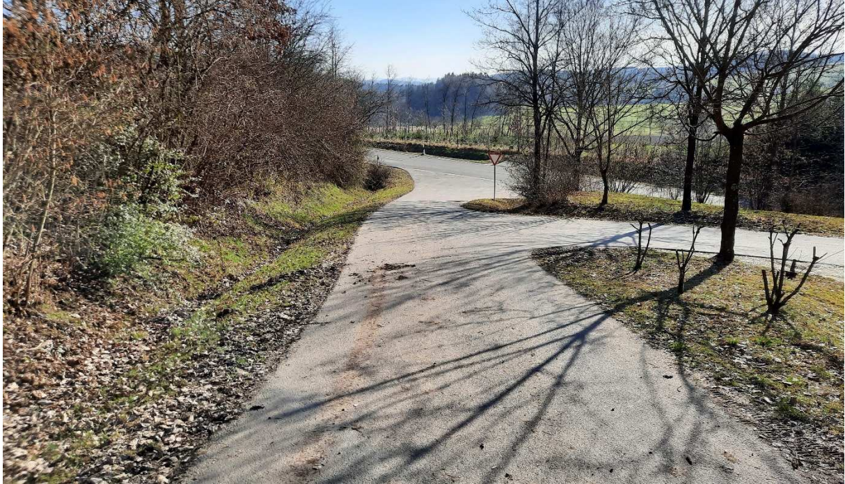
Blick von Norden auf die bestehende Zufahrt zum Friedhof (nach rechts) und auf die Kreisstraße CHA10
