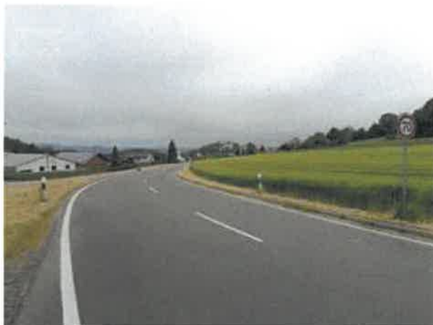
Blick von Straubinger Straße zur Burg würde bei PV-Nutzung rechterhand stark gestört
