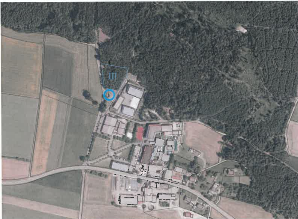
(Abb. 5: – Luftaufnahme Hochbehälter (blauer Kreis) mit Wasserschutzgebiet)
