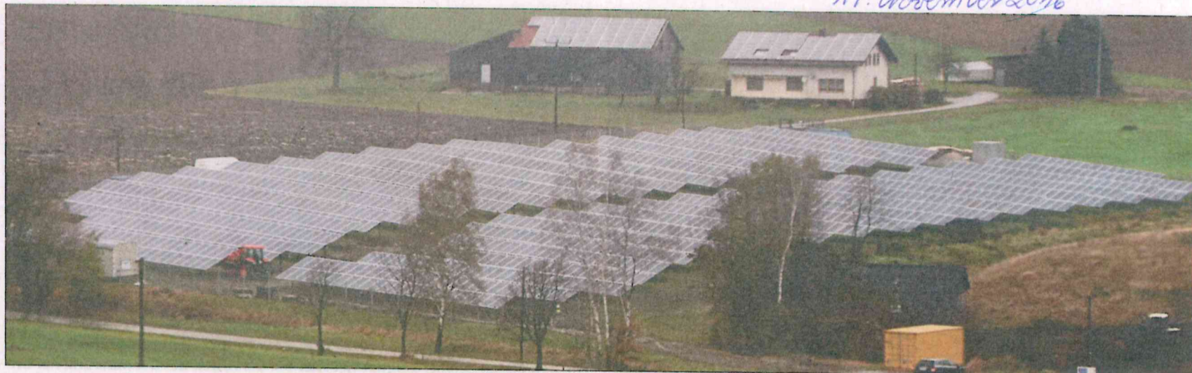
In Sengenbühl erzeugen künftig auf rund einem Hektar 48 Modultische Strom – und ersparen der Umwelt damit in 20 Jahren 5241 Tonnen Kohlenstoffdioxid.
