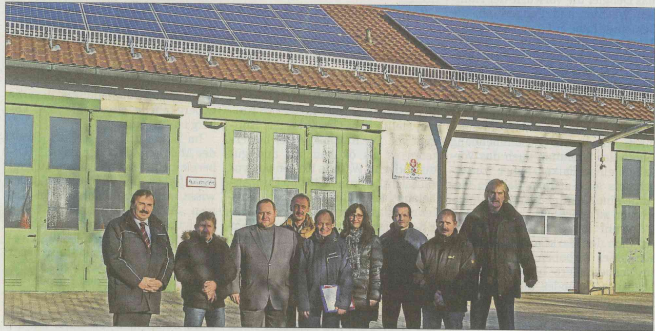
Zwei neue Photovoltaikanlagen wurden kürzlich in Betrieb genommen.
