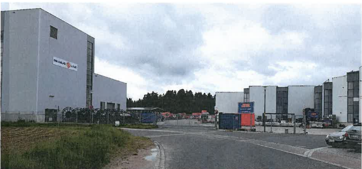
Blick von Osten auf die bestehende Einfahrt ins Betriebsgelände, im Hintergrund bestehende Bebauung
