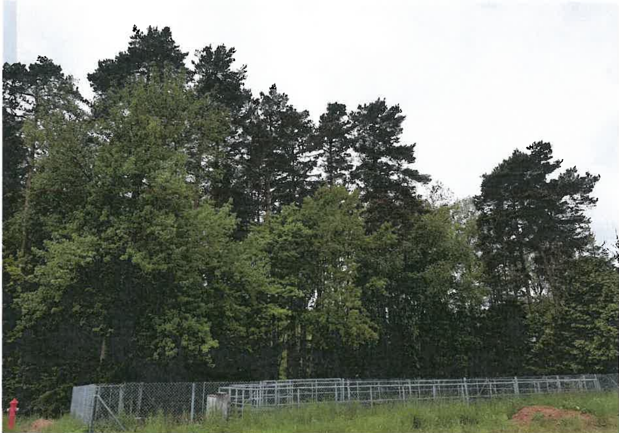
Blick über das bisherige Regenüberlaufbecken auf Flur Nr. 899 und den angrenzenden Waldrand
