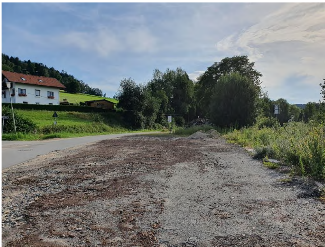
Abb. 4: Lagerplatz mit alter Asphaltfläche
