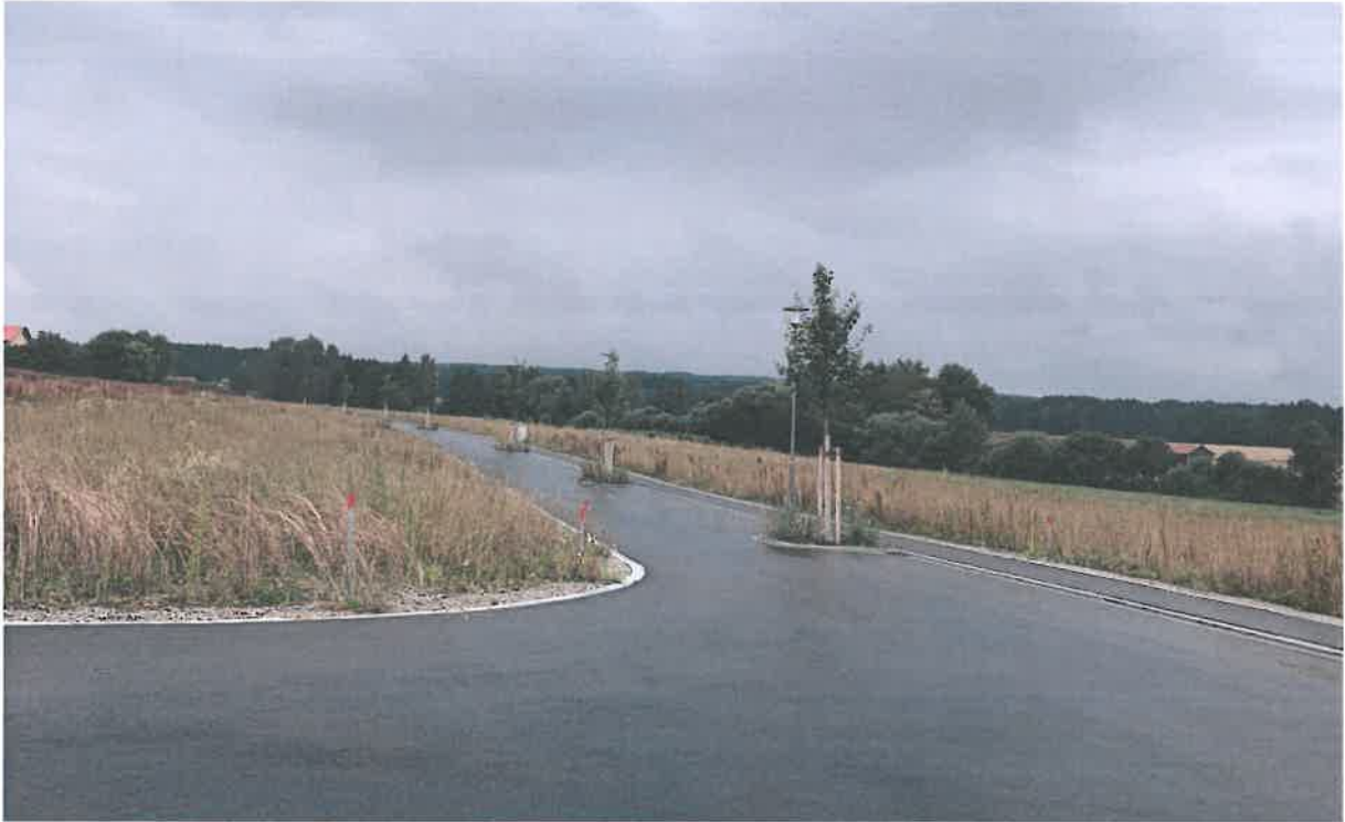
Abb. 4: abgeschlossene Erschließung des Baugebietes „Am Bärnbach“, (Foto: Jocham, Juli 2020)
