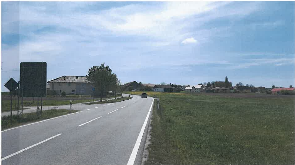
Abb. 2: Bestandsgebäude entlang der Kreisstraße Kr CHA 2 ortseinwärts (Foto: Jocham, Mai 2017)
