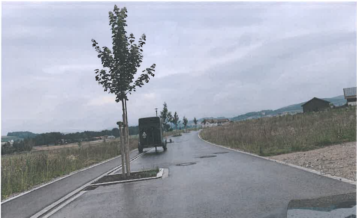
Abb. 5: abgeschlossene Erschließung des Baugebietes „Am Bärnbach“, (Foto: Jocham, Juli 2020)
