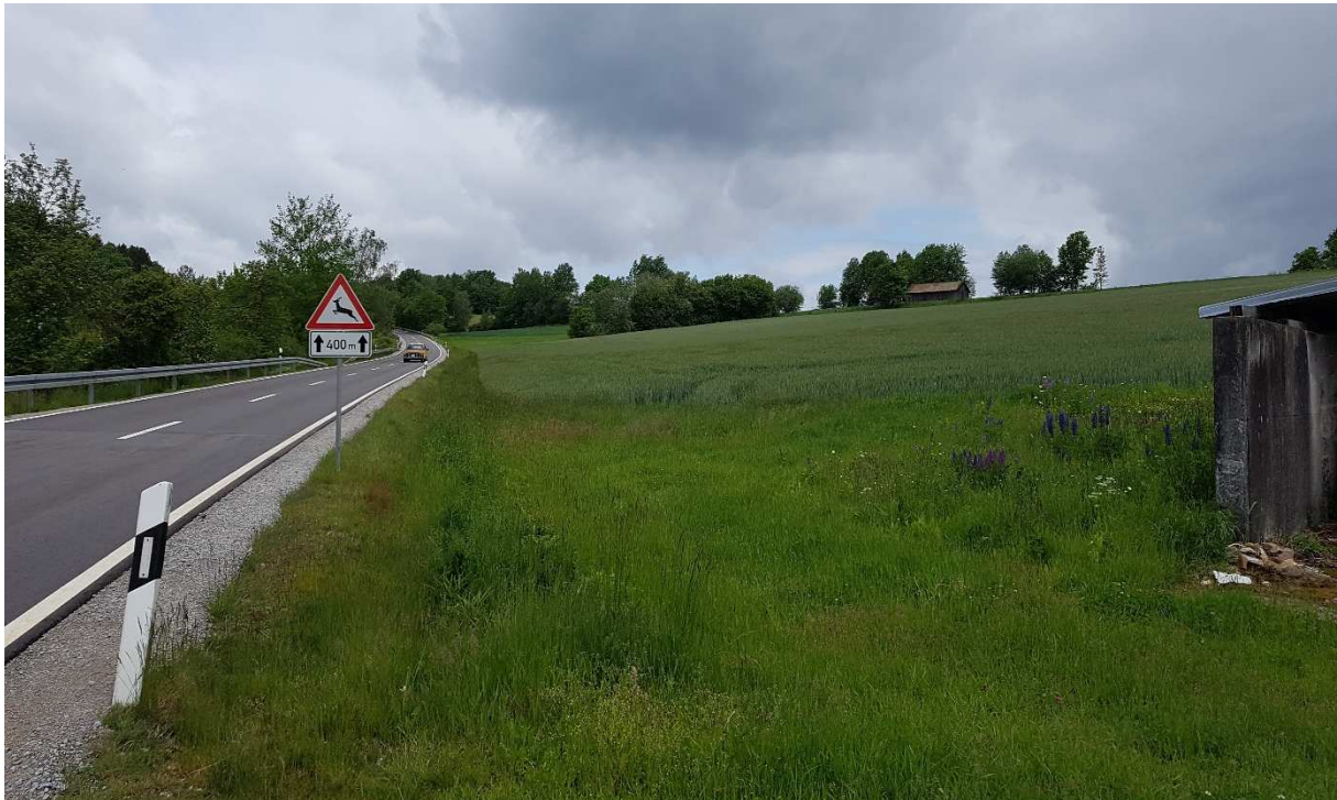
Blick von Süden nach Norden auf die Kreisstraße CHA 19 mit straßenbegleitendem Graben und nach Norden ansteigender Änderungsfläche, rechts: ehem. Schuppen (aktuell ungenutzt)
