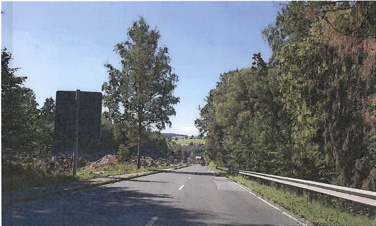
Blick von der Westumgehung in Richtung Süden, links: Änderungsfläche (derzeitiger Abriss)
