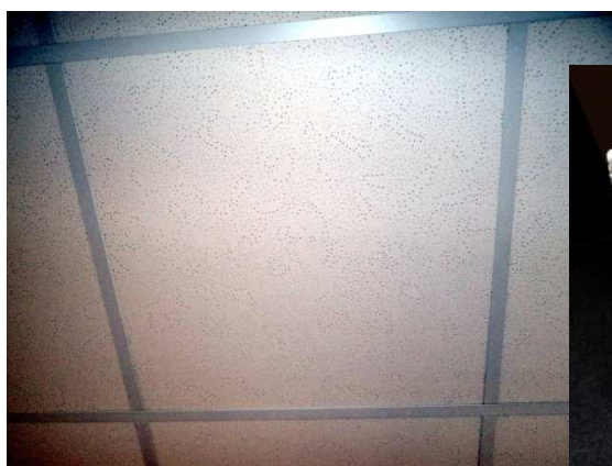
Platten im eingebauten Zustand
