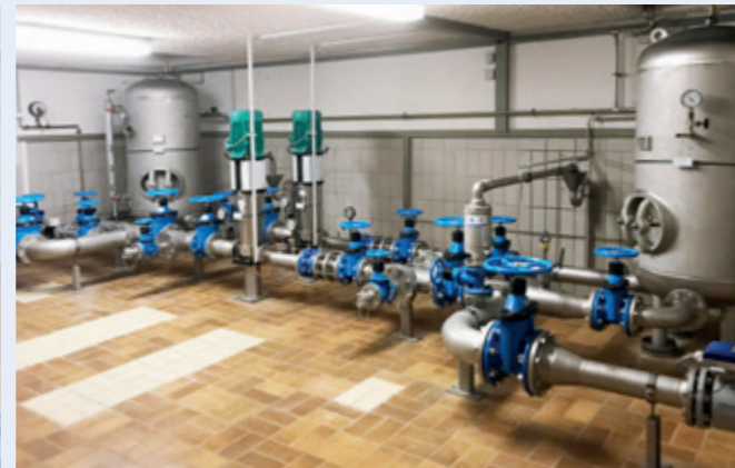
Nach der Modernisierung
