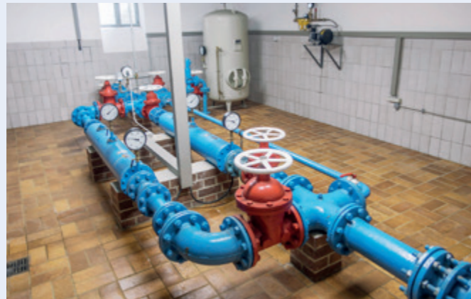
Vor der Modernisierung
