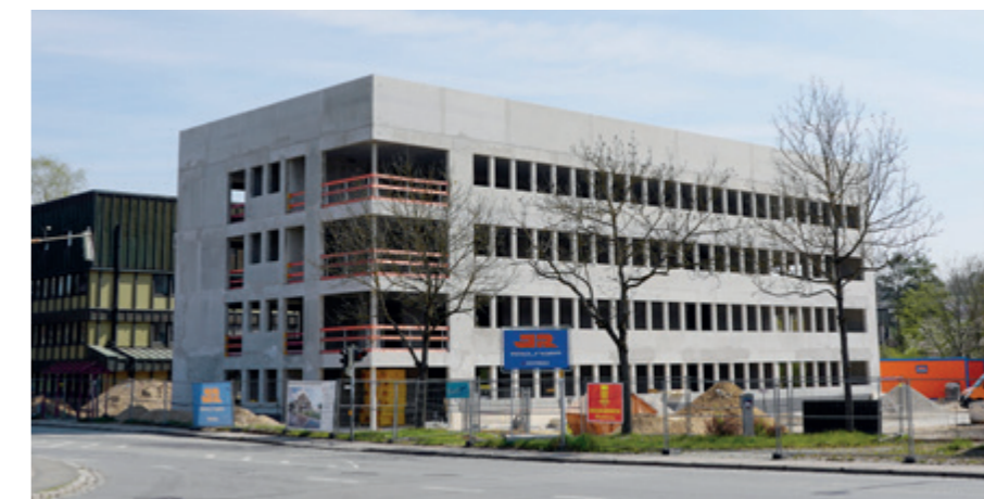
Der Anbau an das Landratsamt Cham im Rohbau
