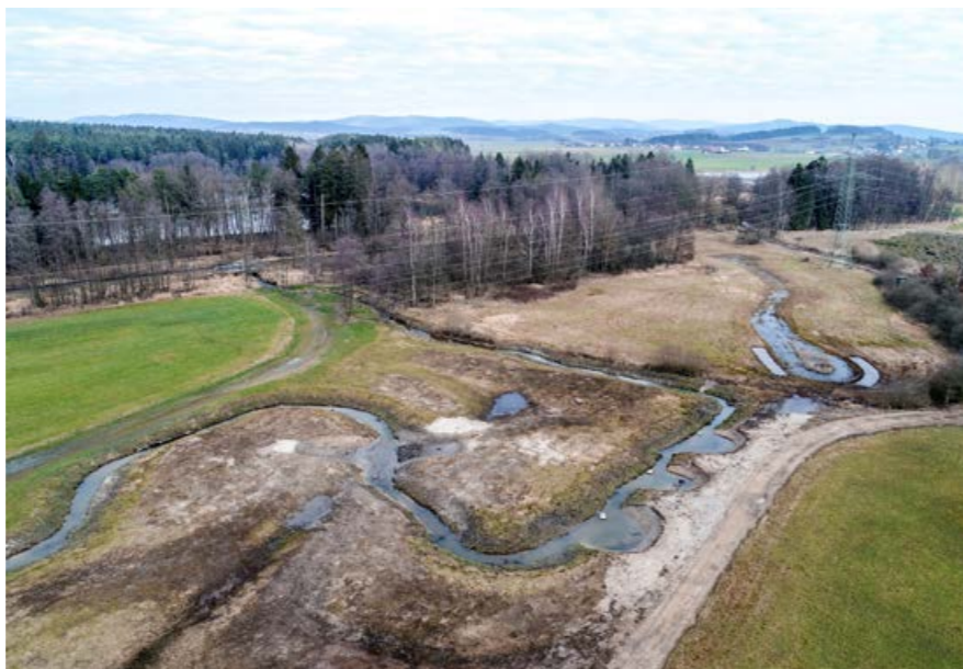
Nördlicher Bauabschnitt mit drei Sandfängen, Foto: Rossbach/Stelzl
