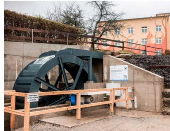
Fertiggestellte Wasserkraftanlage, Foto: Josef Roider
