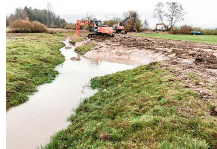
Bau der drei Sandfänge am Oberlauf des Baches, Foto: Stelzl
