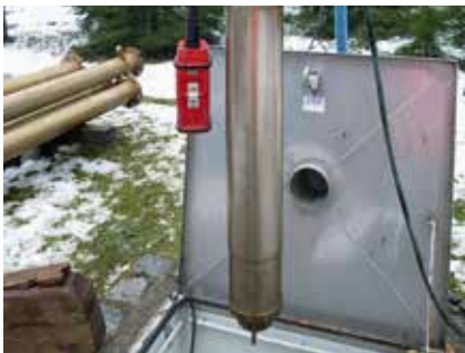
Ausbau der Unterwasserpumpe beim Brunnen 8
