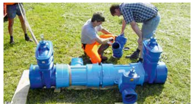
Vorbereitungen außerhalb des Rohrgrabens
