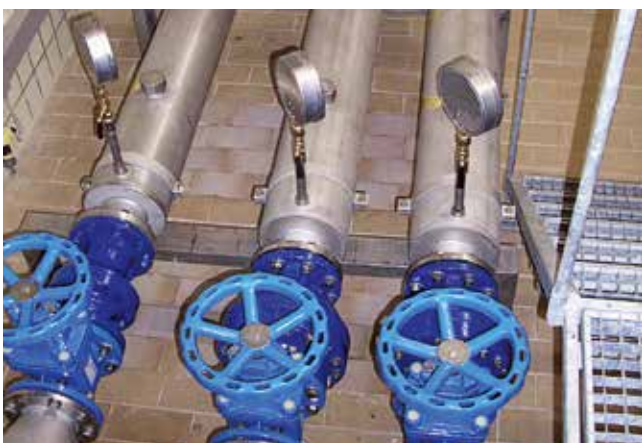
Pumpen mit Drehzahlregelung
