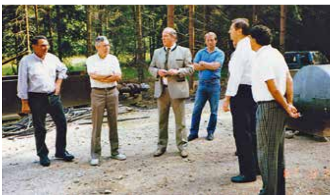
Baustellenbesprechung mit Altlandrat Ernst Girmindl in den 70er Jahren
