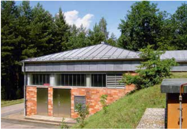
Außenansicht nach der Sanierung 2008
