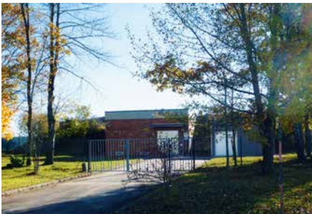
Außenansicht nach der Sanierung 2010
