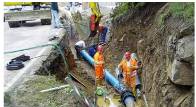
Umlegung der Fernleitung bei Treidling
