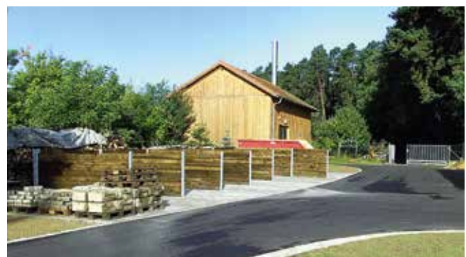
Nebengebäude für Notstromaggregat
