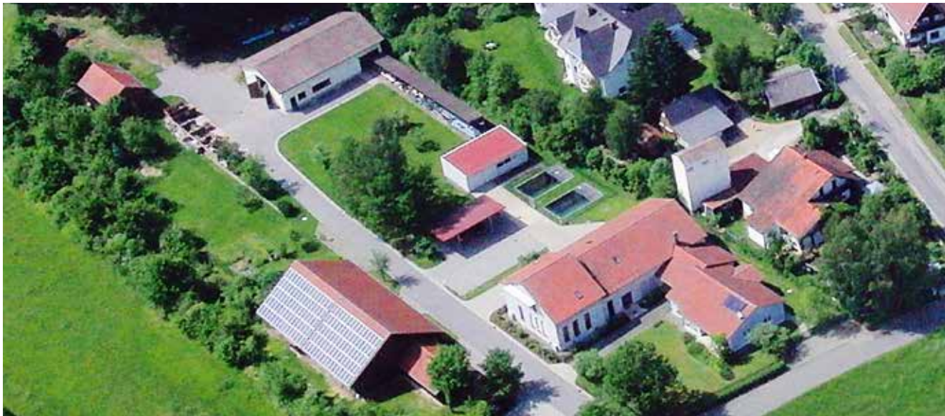
Betriebsgelände Wasserwerk Neubäu
