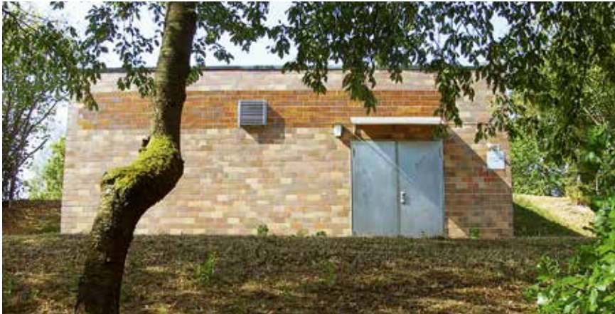
Außenansicht nach der Sanierung 1999
