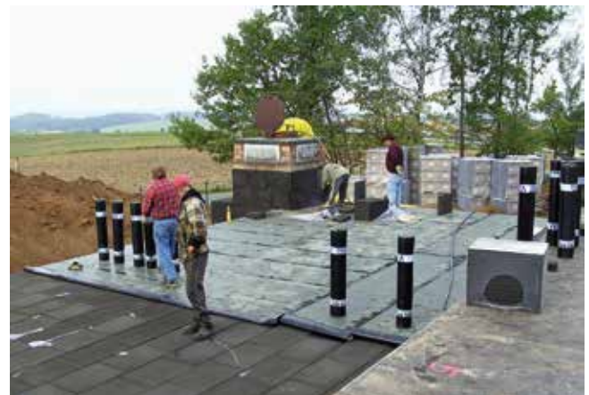
Abdichtung und Isolierung der Behälterdecke
