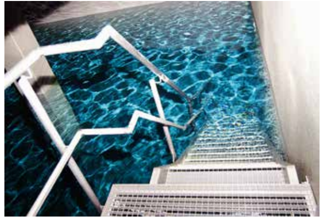
Sanierung der Wasserkammern 2010
