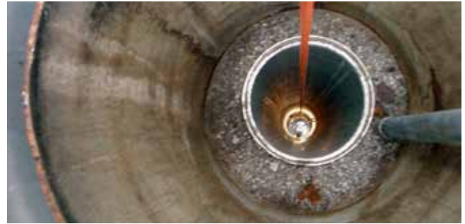
Blick in die Brunnenverrohrung
