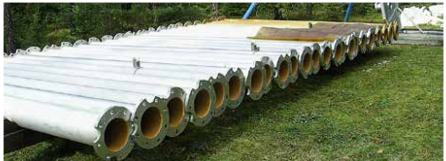
Überholung der Steigleitung beim Brunnen 8
