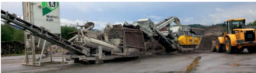
Aufbereitung des pechhaltigen Ausbaumaterials zu einer Fundamentalschicht, die unter den Asphaltsschichten wieder eingebaut wurde
