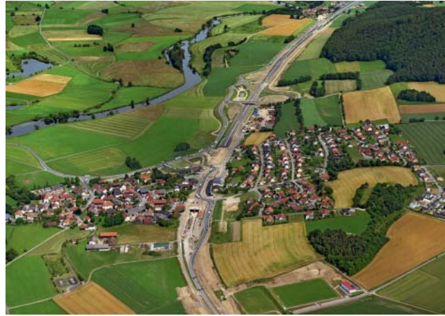
Wetterfeld - Tunnelbereich in Blickrichtung Cham
