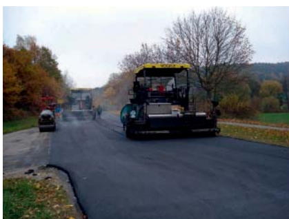
Erneuerung der Deckschicht mit zwei parallel fahrenden Fertigern
