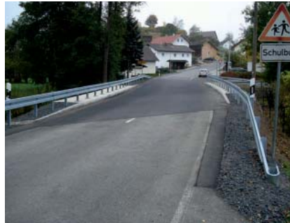
Freie Fahrt über die neue Brücke pünktlich zum Schulbeginn
