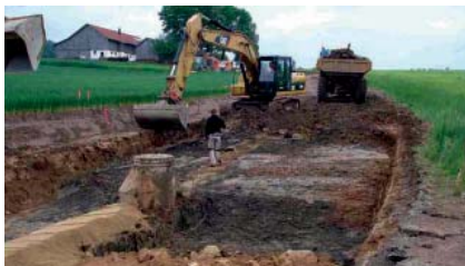
Bodenaustausch mit schwerem Gerät
