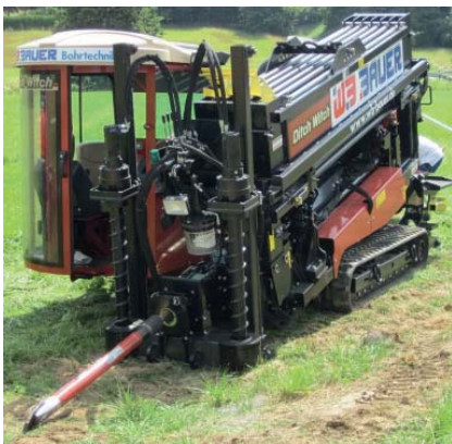
Bohrgerät für das Horizontalspülbohrverfahren
