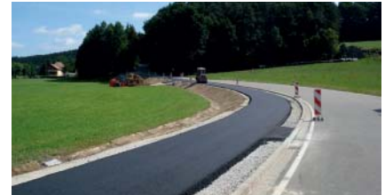
Anbau eines Geh- und Radweges
