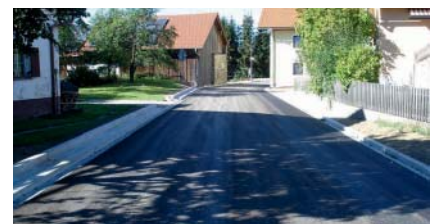
Fertig gestellte Fahrbahn
