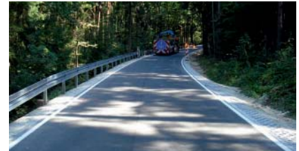
Einbau von Schutzplanken und Rasengittersteinen
