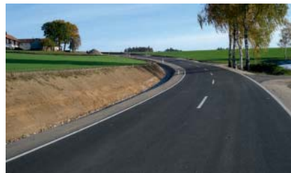
Fertig gestellte Fahrbahn im Bereich Nöbwartling
