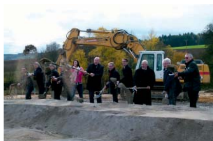
Spatenstich der Ortsumgehung Neubäu
