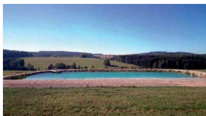
Neu errichteter Speicherteich zum Zwecke der Bewässerung von Gemüseanbauflächen eines Biolandhofs.
