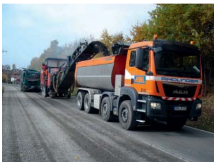
Abfräsen der verbrauchten Deckschicht
