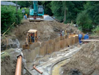
Gründung der Brückenwiderlager auf Spundwänden
