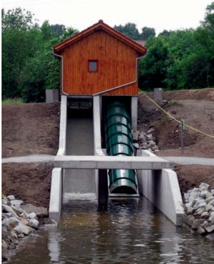
Schnecke Wasserkraftanlage Bruckmühle am Pentinger Bach
