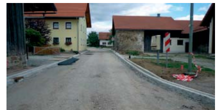
Beseitigung der Engstelle durch Abriss des Backofens
