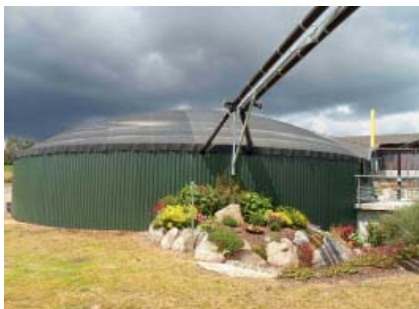
Biogasanlage im Landkreis Cham
