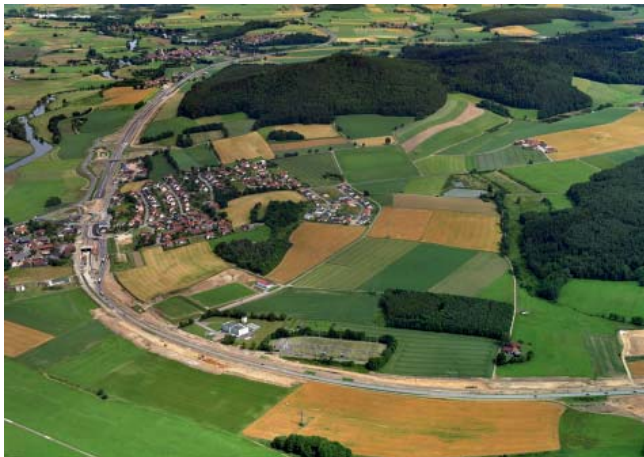
Streckenbau der B 85 westlich von Wetterfeld
