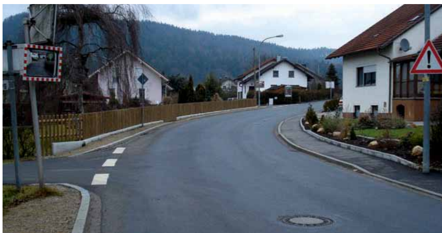
Fertige Straße mit Gehweg
