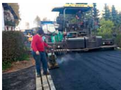
Einbau Tragschicht in Friedendorf
