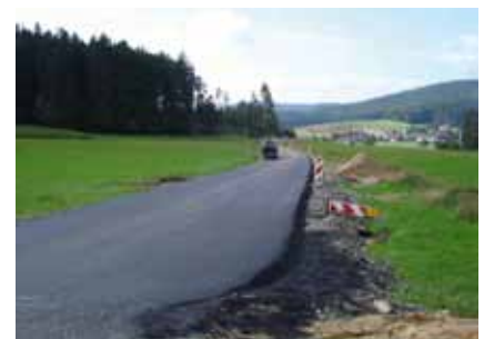
Verbreiterung mit Oberbauverstärkung
