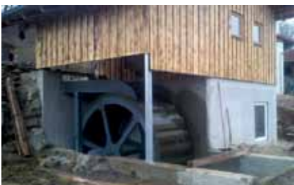
Oberschlächtinges Wasserrad an der Wasserkraftanlage Aumühle am Pentinger Bach. Die Abmessungen der Zellen des Wasserrades gewährleisten einen schadlosen Abstieg der Fische.
