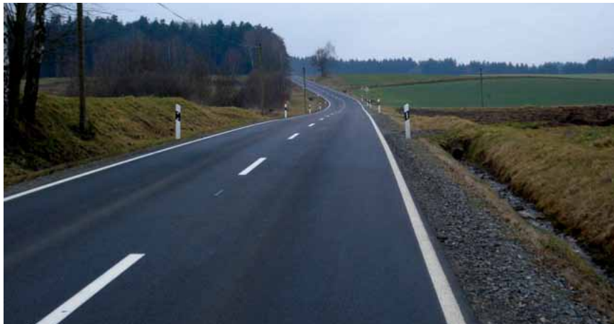
Fertiger Deckenbau nahe Kritzenast
