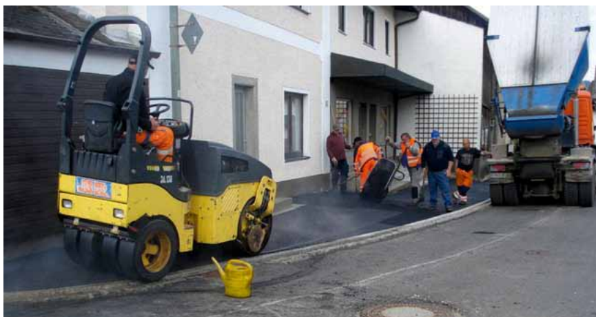
Einbau Deckschicht Gehweg
