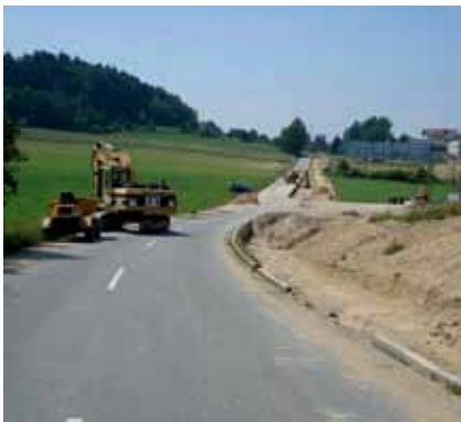
Verbreiterung Straße mit Anbau Geh- und Radweg
