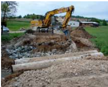
Abbruch mit Provisorium für den „Hiltensbach“
