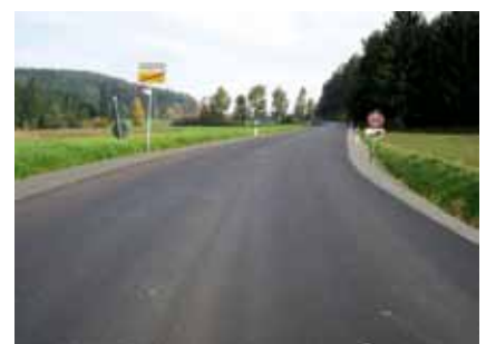
Fertige Straße mit Banketten
