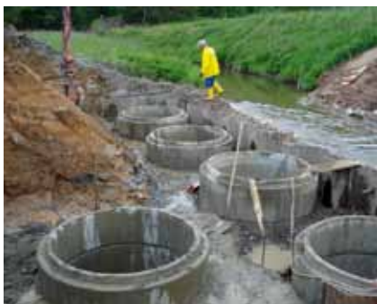
Spundwand und Brunnengründung
