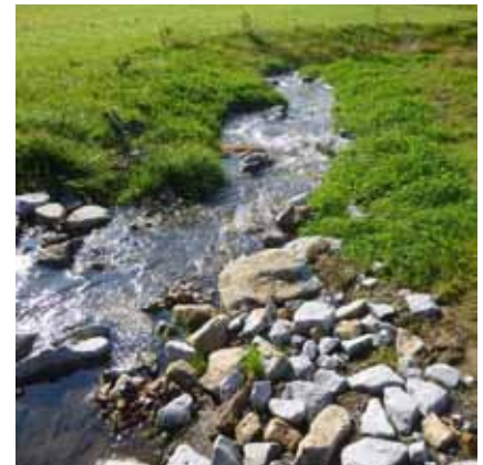
Fischwanderhilfe in Form eines natürlichen Umgehungsgerinnes, errichtet an einer Wasserkraftanlage in Obervierau am Klinglbach
