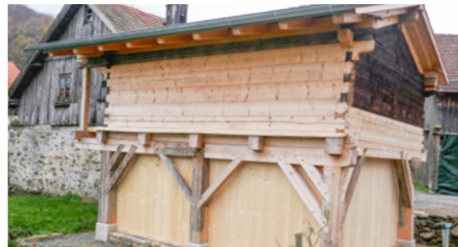
Markus und Gaby Bauer für die Renovierung des Troidkastens in Waldmünchen-Ulrichsgrün
