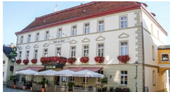
Beate Späth für die Fassadensanierung des Hotels „Zur Post“ in Lam
