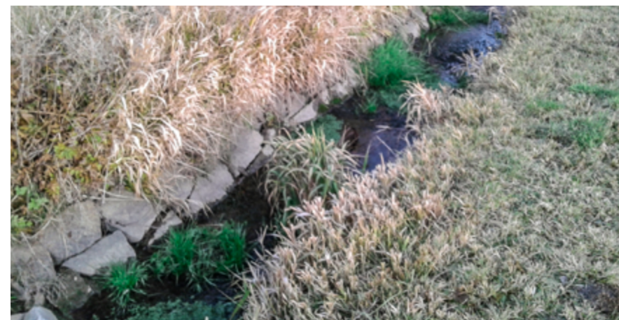
Altes Bachbett mit linearem Verlauf, versteinter Sohle und gepflasterten Ufern.
